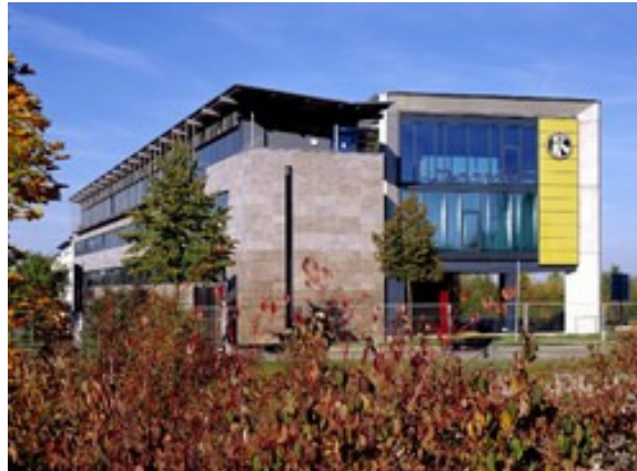
Abb. 1: Hauptsitz der F.Kirchhoff AG in Echterdingen Quelle: F.Kirchhoff AG
